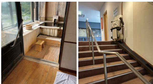
階段には昇降機が設置、浴室・トイレは完全バリアフリー
